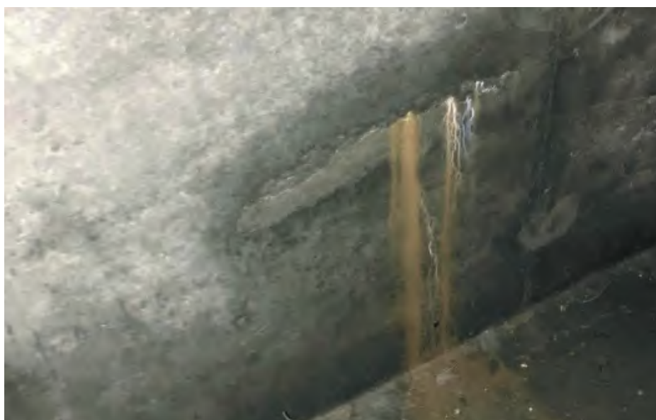
Рисунок 7.2.33 – Безнапорная течь
