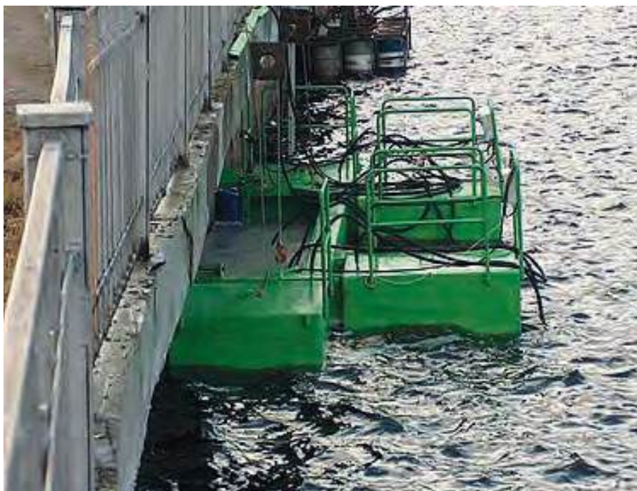
Рисунок 7.4.10 – Металлическая кессонная камера для ремонта структурно поврежденного бетона в зоне переменного уровня воды
