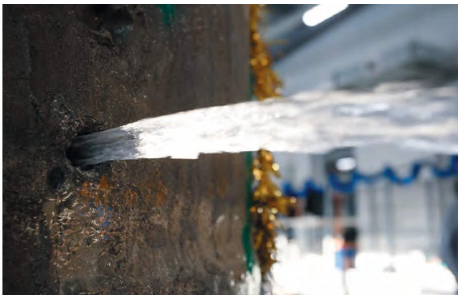
Рисунок 7.2.34 – Напорная течь
