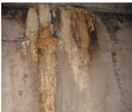
Рисунок 6.7.2 – Транспортно-кабельный туннель: а – выходной оголовок туннеля; б – фильтрация воды через стены туннеля с выносом свободной извести и продуктов коррозии арматуры
