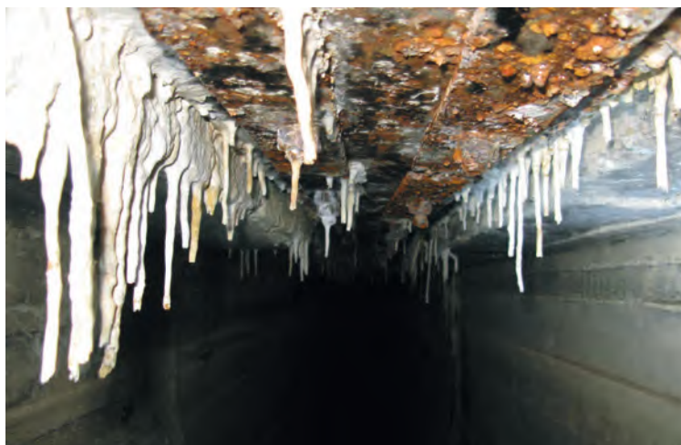
Рисунок 5.1 – Фильтрация воды через потолочное уплотнение деформационного шва с выносом гидроксида кальция и образованием «сталактитов» в соединительной галерее здания ГЭС
