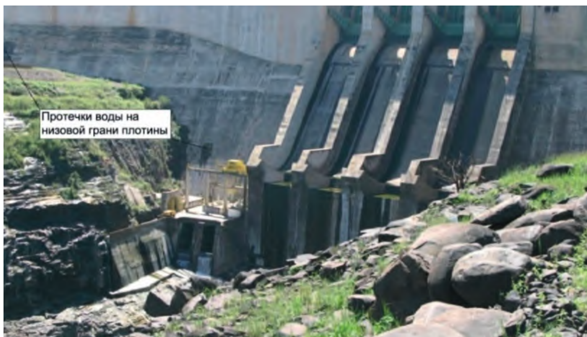
Рисунок 6.2.3 – Плотина из укатанного бетона
